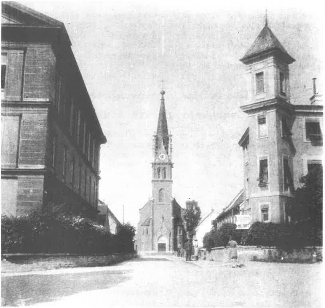
Blick von der Oberdillinger Straße auf die Evang. Stadtkirche (50er Jahre)
